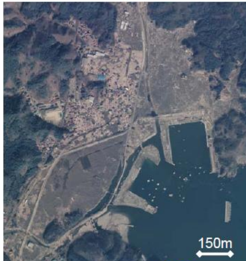
被災後(平成23年3月13日撮影)
