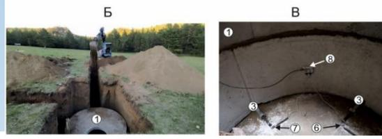
**Подземная часть:** схема датчиков деформации (А) и фото строительства бункера (Б-В)
