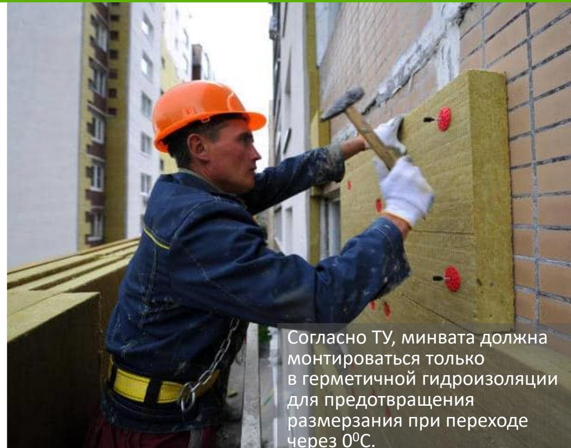
Согласно ТУ, минвата должна монтироваться только в герметичной гидроизоляции для предотвращения разморзания при переходе через 0°C.
